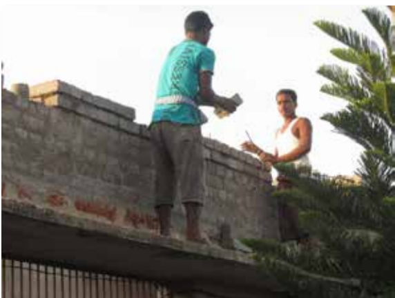
Das Dach im Rohzustand
